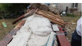
rebouchage au plâtre, apprentissage du geste: jeter le plâtre comme un revers au tennis! Egaliser à la taloche, lisser à la taloche éponge qui laisse dans le plâtre des sillons servant à répartir l'eau de pluie sur toute la surface, empêchant la formation de sillons. Modification de l'échafaudage. (taloche, taloche éponge)
