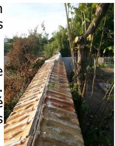
La préparation: enlèvement du lierre et d'autres plantes qui ont causé d'énormes dégâts, les racines entrant profondément dans le mur (sécateur et brosse wc), purge des pierres et des plâtras, et des enduits (assez peu), grattage des murs (ventouses du lierre) (brosse métallique), installation de l'échafaudage (échafaudage)
